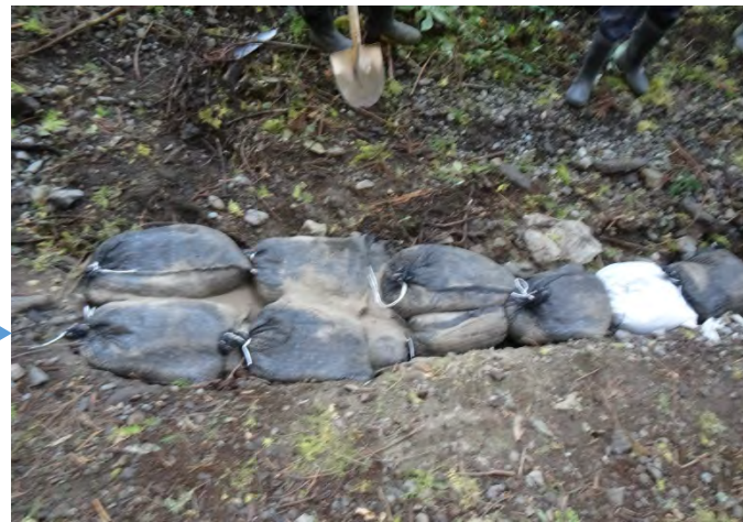
・土嚢+スコリアセメントによる補修
